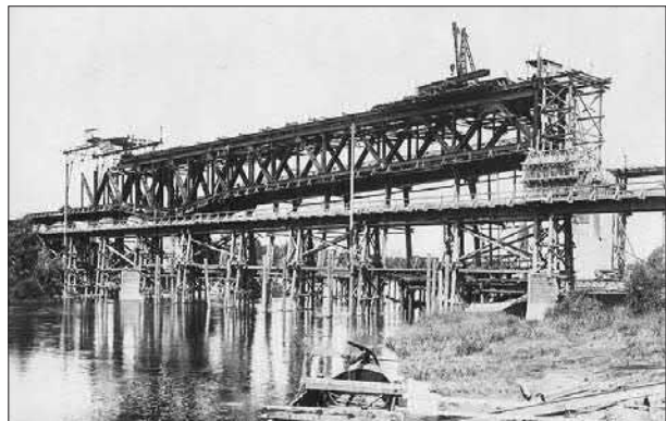
Het spoorwegviaduct met bouwbrug.
